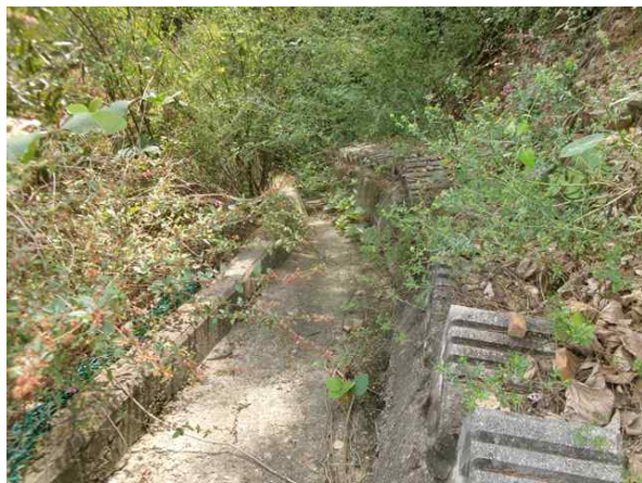
산마루측구, 점검계단 전경
